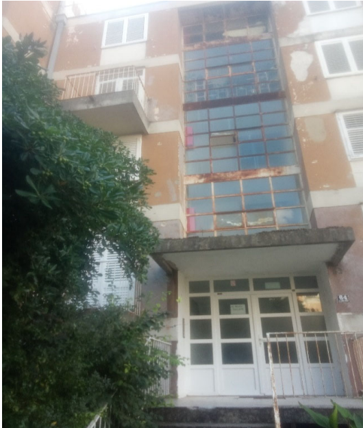
Fotografije postojećeg stanja:
