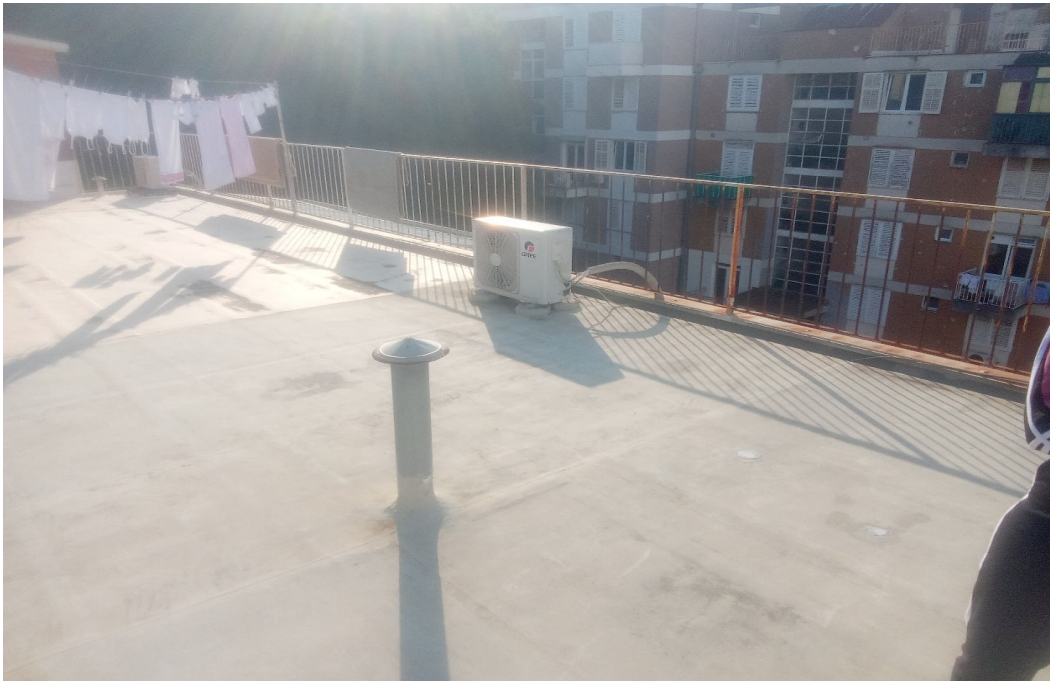
Fotografije postojećeg stanja:
