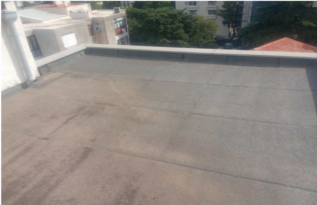
Fotografije postojećeg stanja:
