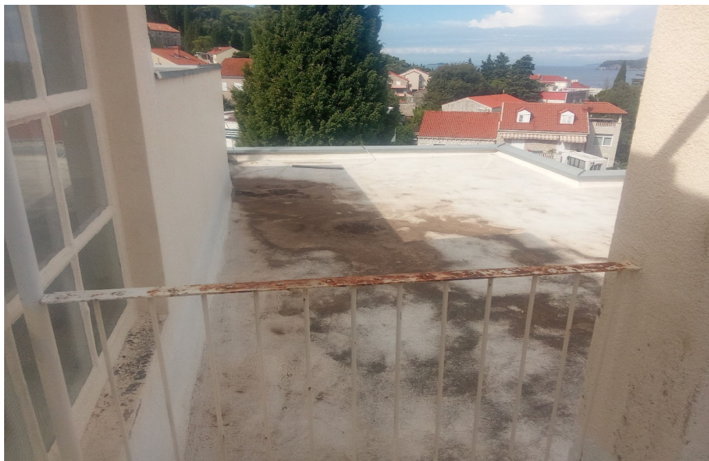
Fotografije postojećeg stanja:
